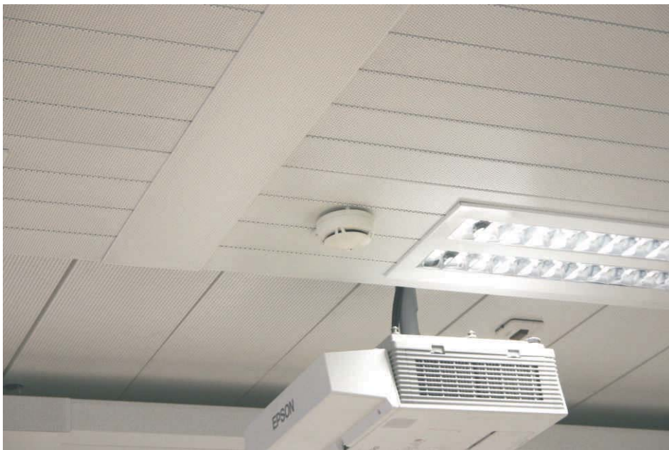
Kühlsegel in Akustikausführung Sonderausführung mit integrierten Langfeldleuchten und Rauchmeldern
